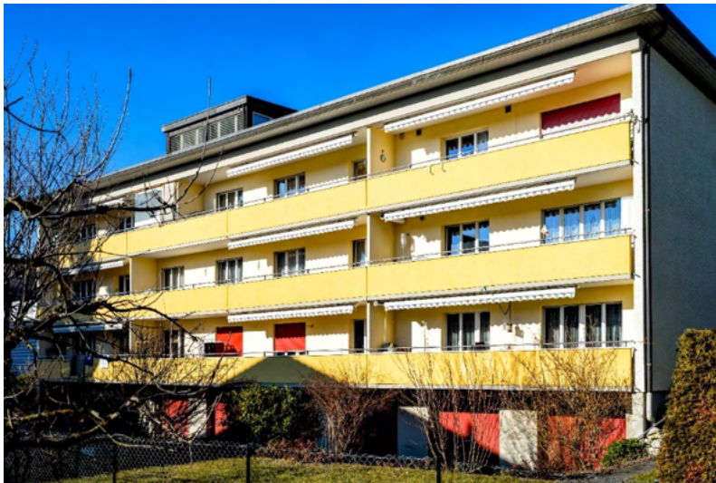
Das Mehrfamilienhaus Bahnweg 22 gehört der Baugenossenschaft Sense.
