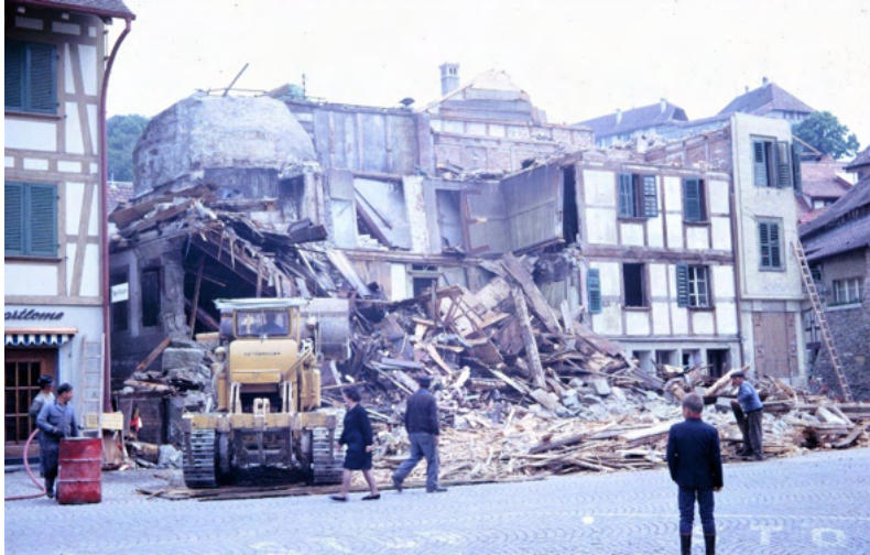
Abbruch des Ruprecht- und des Staufferhauses
