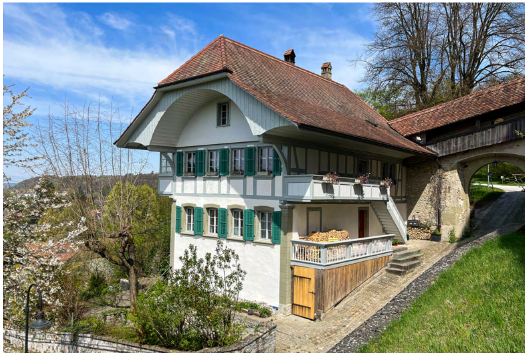
Schlossstöckli, nach der Aussensanierung Ende 2021
