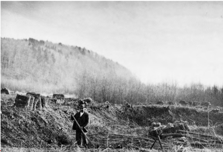
Rodungsarbeiten in den 1940er Jahren durch internierte Italiener
