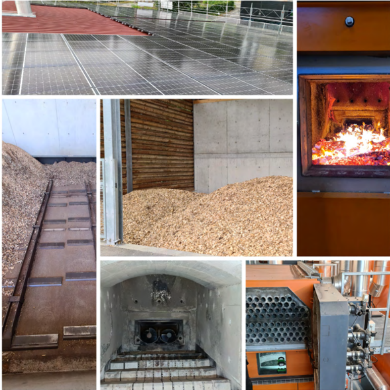
Impressionen der Heizzentrale
