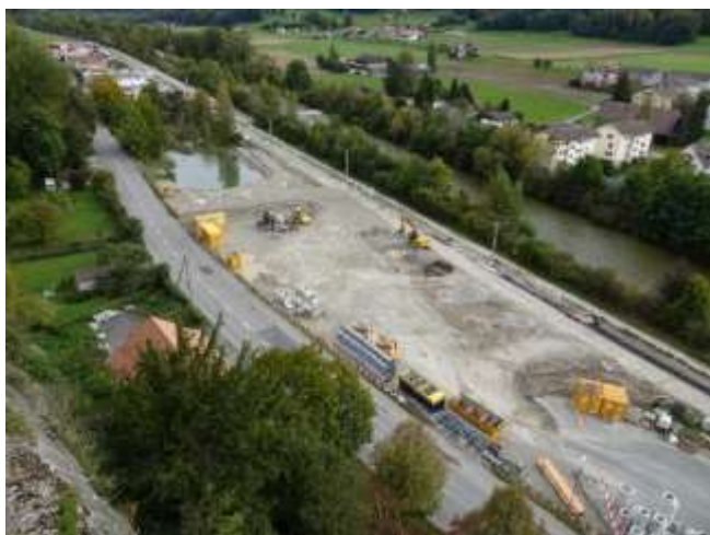
Abb. 1: Baustelle Bahnhofverschiebung und Parkplätze.
