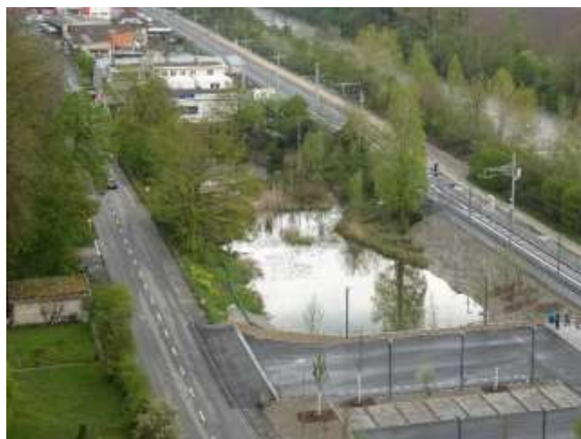
Abb. 2: Neu erstellter Parkplatz.
